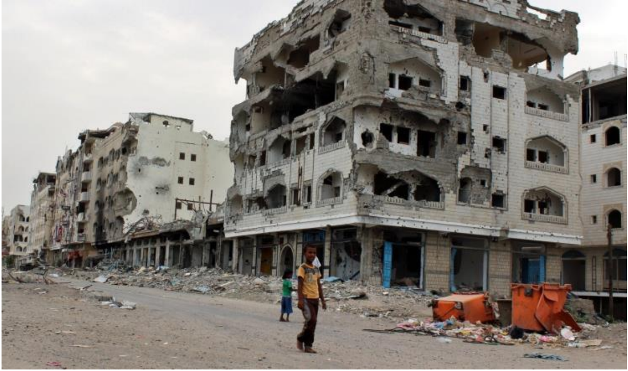
مبانٍ مدمرة في عدن، وأضرار واسعة في رأس المال المادي/القطاع الخدماتي مثل الكهرباء والمياه والطرق (الأوروبية)
